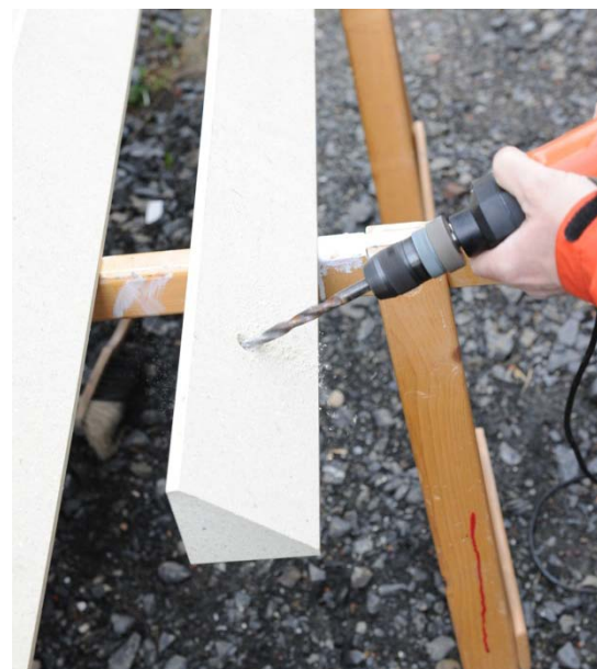
Wstępne nawiercenie otworów pod śruby zabezpieczające
